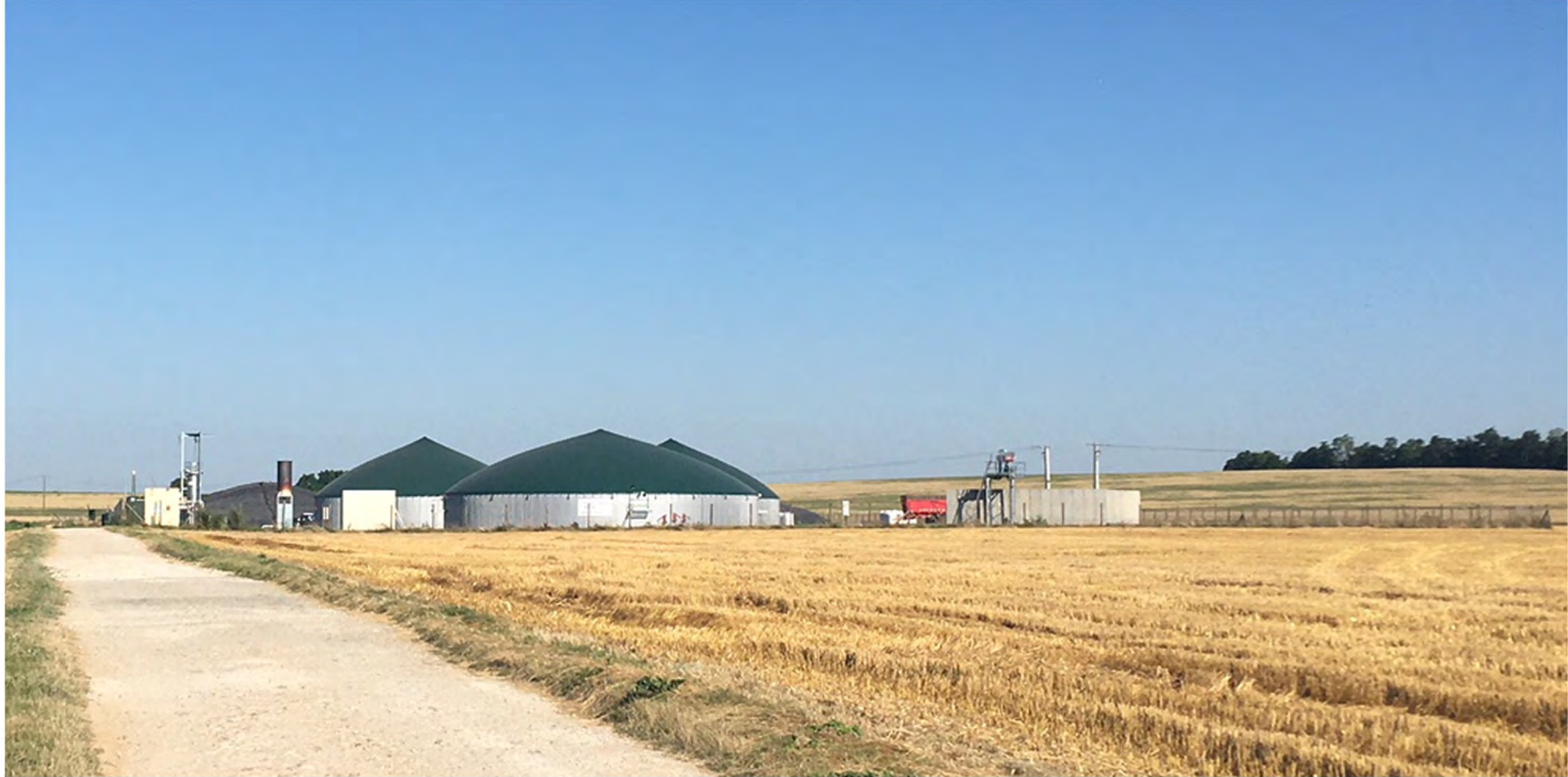
PC6 - Photographie de l'existant
